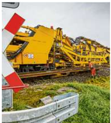
So sah es während der Sanierung aus. Foto: Matthias Kessler
